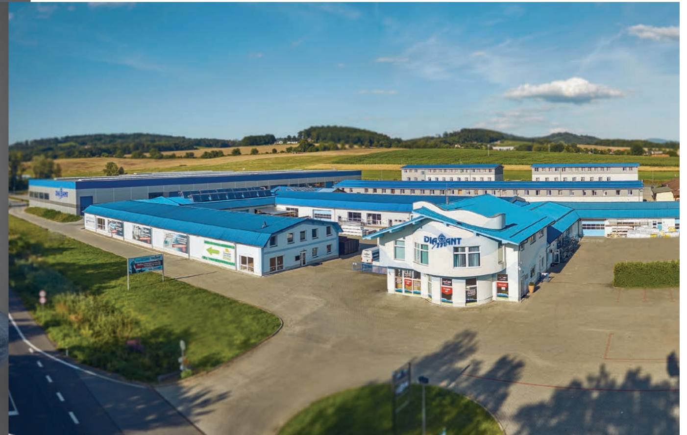
Im Jahr 2020 wurde eine neue Produktionshalle für Edelstahlbecken mit einer Fläche von 7.000 m 2 fertiggestellt. Die gesamte Produktion findet auf 17.000 m 2 großer Produktionsfläche in Valašské Meziříčí statt.
